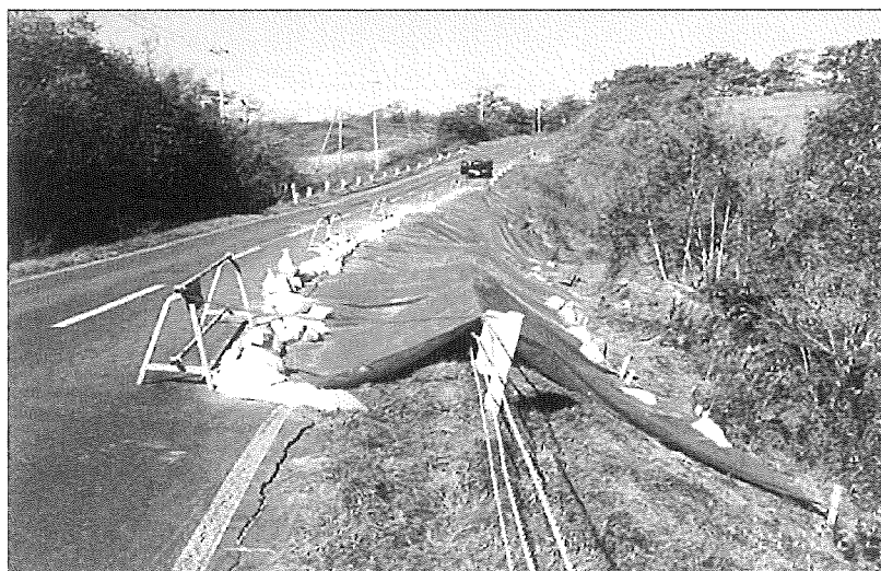
(a) - 1 A型バリケードとロープによる通行止め
