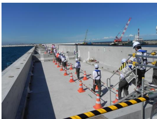
⑤ 現場の様子
