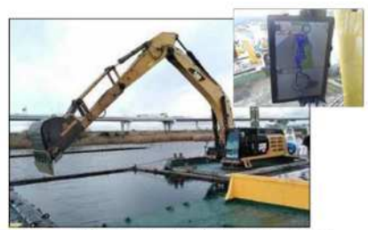
工種名：浚渫工(バックホウ浚渫船)(ICT)
