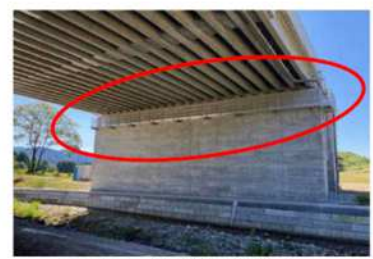
工種名：橋梁検査路架設工
